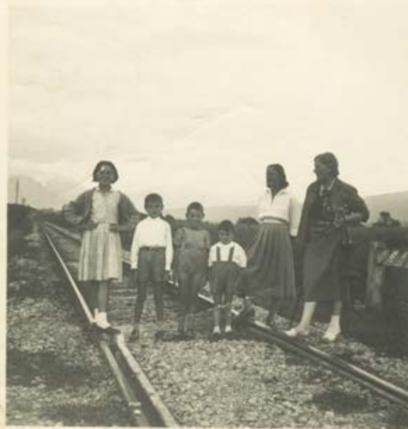
31/8/1957 Gemma, Pierino, Pierangelo e Giuliano e le "paronsine" Zadra... aspettano il treno
